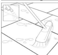
6. Arrosez la surface attentivement en utilisant un tuyau d'arrosage avec un jet d'eau à angle large. Balayez le produit restant avec un balai à poils doux. Pour obtenir une parfaite étanchéité, laissez sécher un peu et pressez les joints de nouveau avec le fer à rejointoyer. Laissez sécher le produit. Weatherpoint sera complètement résistant aux charges après 3 jours de temps chaud et sec d'affilé, avec une humidité de 65% maximum.
